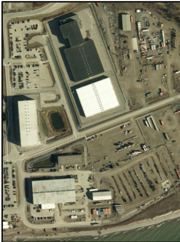
Figure 1.4 : Vue aérienne de l'installation de gestion des déchets de Darlington
